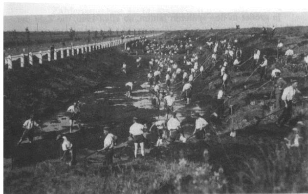
Häftlinge bei der Arbeit im Moor: Anlage von Entwässerungsgräben.
